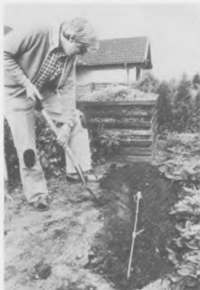
OZ9NI efter antenntesten, forsøger at forbedre jordplanet på en Ringo Ranger. (Foto OZ9TM).
