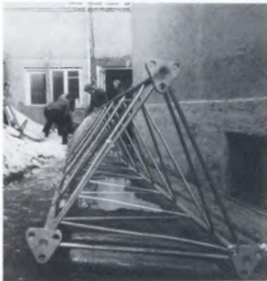
Første sektion af masten er ved at blive gjort klar til at blive hejst på plads.
