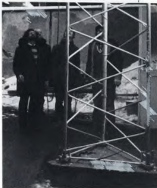
Arbejdet udført, et tilfældigt arbejds hold betragter vidunderet: en 18,6 meter mast.
