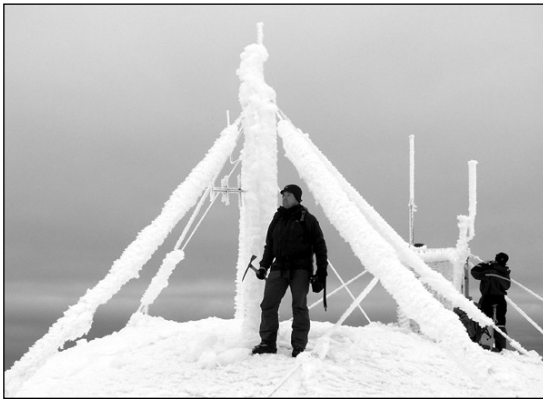
Fotoet viser JX7SIX's QTH IQ50RX. Som man kan se, er det nødvendigt at tage højde for ekstrem isbelastning på antennerne.
