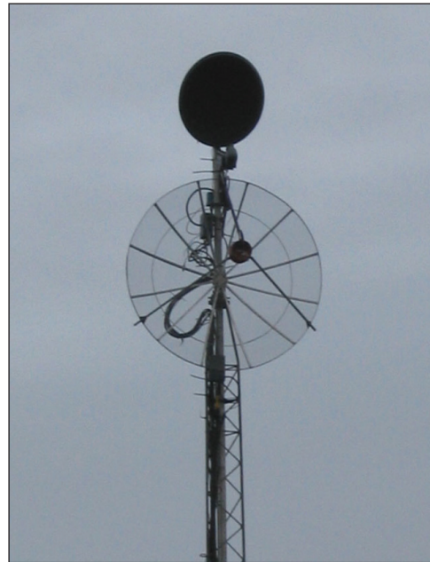
OZ1FF's nye antennesystem til mikrobølgebåndene. Øverst er parabolantennen til 10 og 24 GHz og nederst sidder en 1,5 m trådparabol med fødesystem til 1296/2320/5760 MHz.
