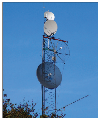
Det antenneudstyr Kjeld, OZ1FF, anvendte til 24 GHz DX-rekorden er vist i april OZ. Her ses SM6AFV's antennesystem til mikrobølgebåndene. 24 GHz parabolen sidder øverst i masten, som er placeret 500 m fra hans ordinære QTH. Antennehøjden er ca. 250 m over havet.
