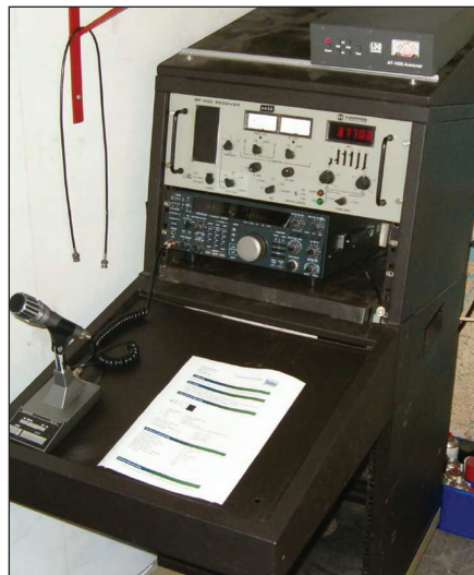
Påbegyndt ombygning af HF rig i rack
