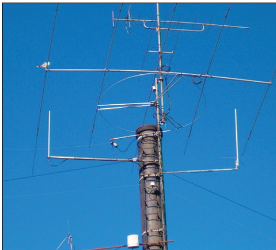
Ny UHF repeater antenne på den lange udlæggerarm
