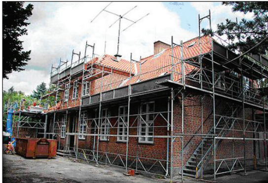
Renovationsarbejdet af huset forsætter stadig, blandt andet med nyt tag og forstærkning af tagkonstruktionen. Foto: OZ1AXG Flemming
