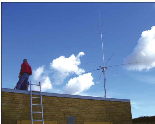
Så er antennen på plads
