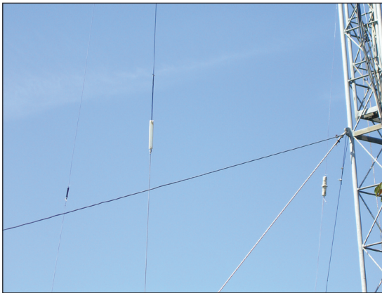
Figur 3. Coaxialkabel med strømbalun og absorberende toroider.
