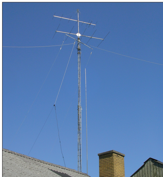
Figur 2. Yagi sloper, øverste del
