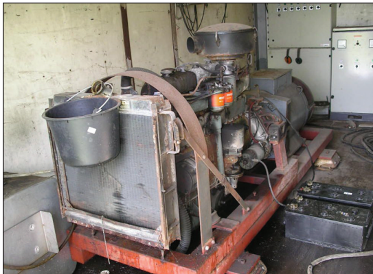
Den "lille" generator (150 KW)
