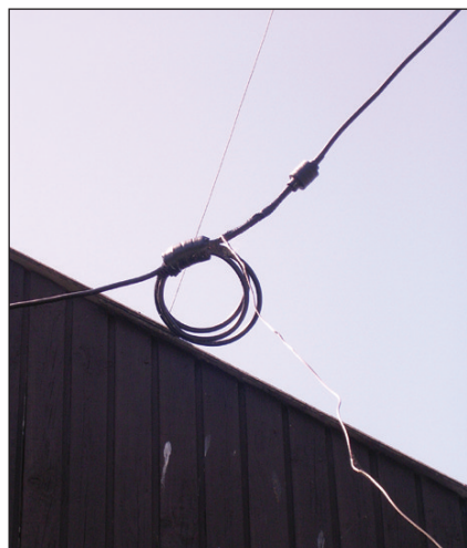
Figur 7. Impulsafleder mod induceret lynstrøm
