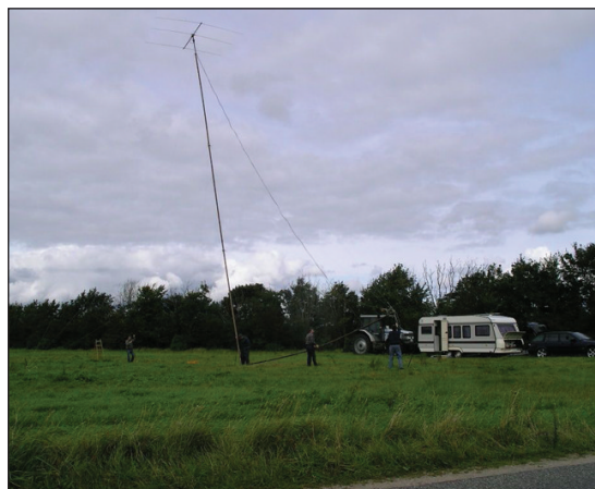
10 meter antennen er næsten oppe
