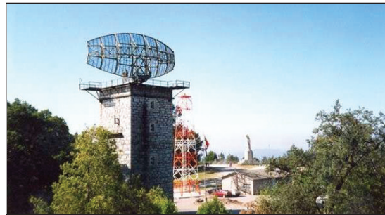
FPS-88, en videreudvikling af FPS-8, opstillet i Portugal i 1966, men kasseret i 1990, hvor man gik over til POS-CCR-systemet. Begge FPS-radarer var af en vis interesse for 21cm folket, da de sendte mellem 1290 og 1380 MHz med impulser på 1 Megawatt. Omløbstid 6 sekunder.
