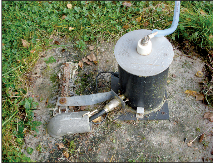
Figur 5. Fødepunktet med isolator
