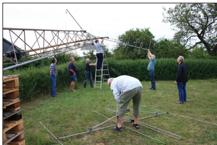
Antenne montage. Heldigt at vi havde godt vejr til arbejdet.
