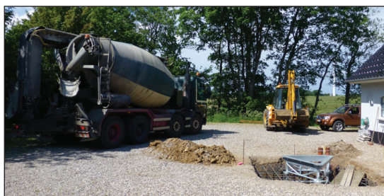
Beton bilen lægger af
