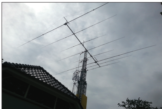
80-40-30 m. Beamens på plads
