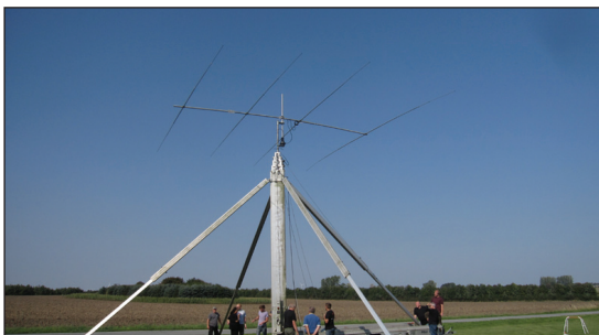
20 Meter antennen klar til hejsning
